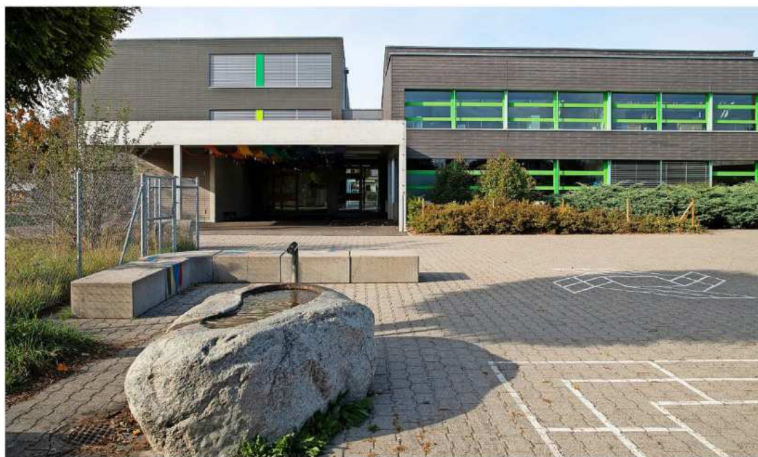
Das Schulhaus Stadelfeld könnte erweitert werden. Denn hier hat die Gemeinde Landreserven, hier kann sie noch wachsen. Foto: Christian Pfander
